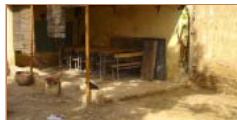
La 2eme terrasse en cours de réfection.
